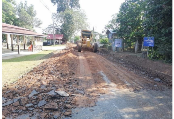
ภาพระหว่างดำเนินการก่อสร้าง
