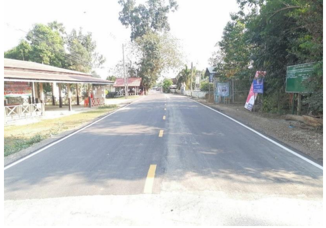
ภาพดำเนินการก่อสร้างแล้วเสร็จ
