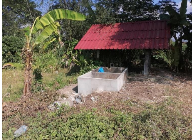
ภาพดำเนินการก่อสร้างแล้วเสร็จ
