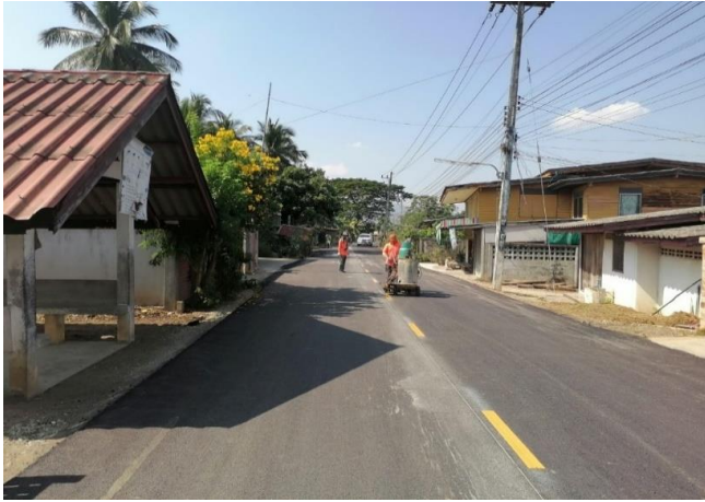
ภาพระหว่างดำเนินการก่อสร้าง
