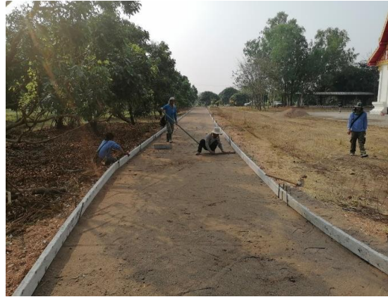
ภาพระหว่างดำเนินการก่อสร้าง
