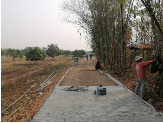
ภาพระหว่างดำเนินการก่อสร้าง
